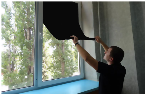
Рис. 13 — Светомаскировка с использованием светозащитного устройства
