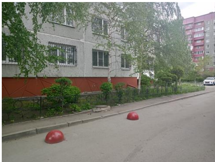
г. Омск, Центральный АО, в 6 м. северо-западнее многоквартирного дома 119 по ул. Омской
