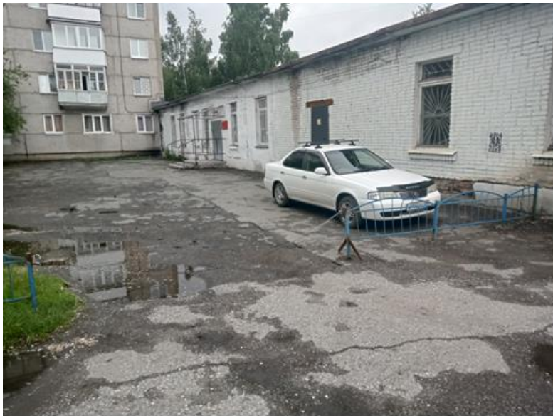
г. Омск, Ленинский АО, в 1-6 м. юго-восточнее здания 2А по ул. Молодогвардейской
