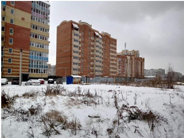
г. Омск, Ленинский АО, в 20-39 м севернее многоквартирного дома № 2 по ул. Светловская
