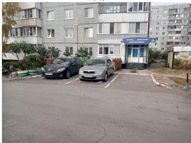
г. Омск, Октябрьский АО, в 12 м юго-восточнее многоквартирного дома № 18/2 по ул. Кирова
