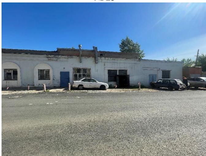
г. Омск, Советский АО, в 1 м юго-западнее здания 15А по ул. 1-й Затонской
