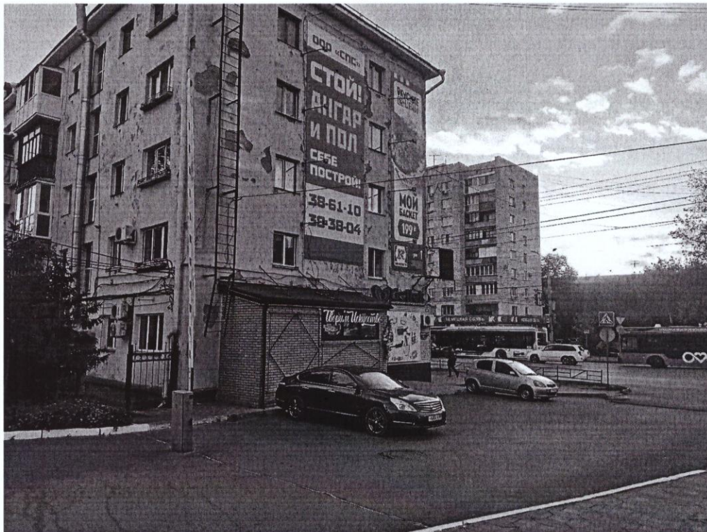
г. Омск, Ленинский АО, проспект Карла Маркса, дом 67 (6 м северо-восточнее)
