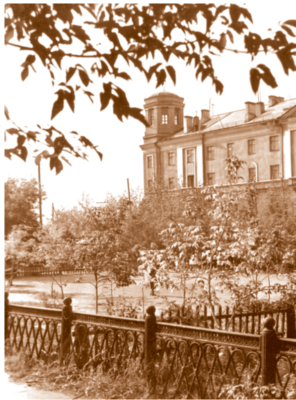
Зеленый массив возле жилого дома. Сквер на ул. Б. Хмельницкого 18 . 1950-е
