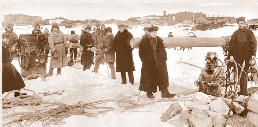
Прокладка водопроводной трубы по р. Омь. 1915
