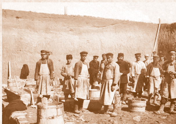
На строительстве дымовой трубы Омских железнодорожных мастерских. 2 июня 1895 г.
