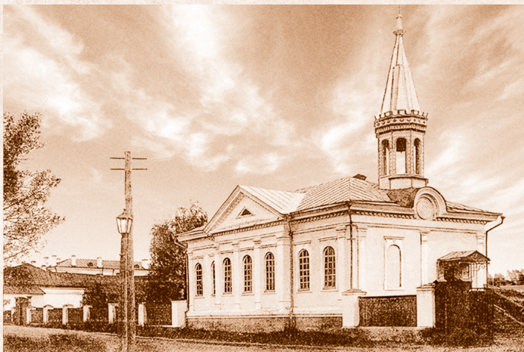
Лютеранская кирха в крепости после перестройки. Начало XX в.
