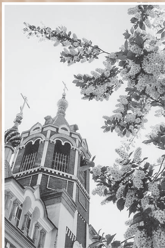
Церковь во имя иконы Божьей Матери «Всех скорбящих Радости» на территории военного госпиталя после реконструкции* (ул. Гусарова, 4, кор.5)
