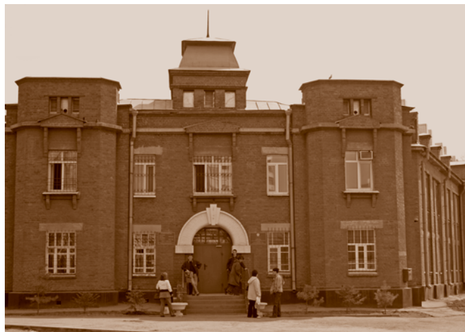
Дом-общежитие для рабочих Сибметаллтреста. Фрагмент. Фотография 2008 г. Е. М. Кавлакан
