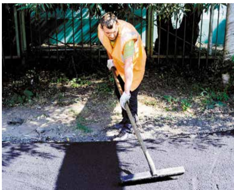
Только в Кировском округе отремонтировано 23 тротуара общей площадью 10 710 квадратных метров
