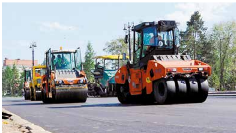
На ремонт городских дорог затрачено 1 млрд. 275 млн руб.
