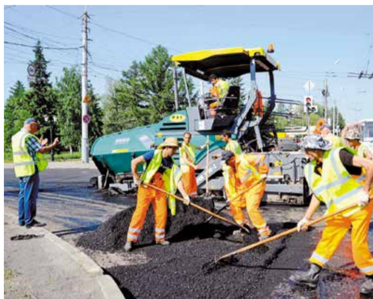
Замена асфальтобетонного покрытия велась по всей ширине проезжей части
