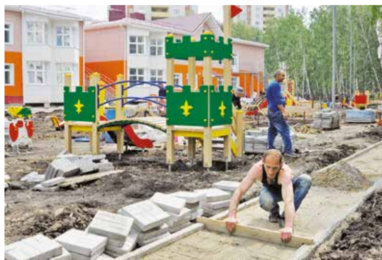
Строительство детского сада № 95
