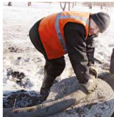
Работы по предотвращению подтопления ведутся в ежедневном режиме
