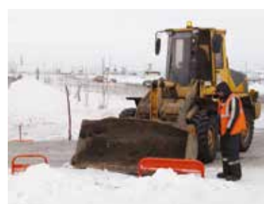
Демонтаж блокираторов у домов № 1-3 и № 8 по улице Крупской
