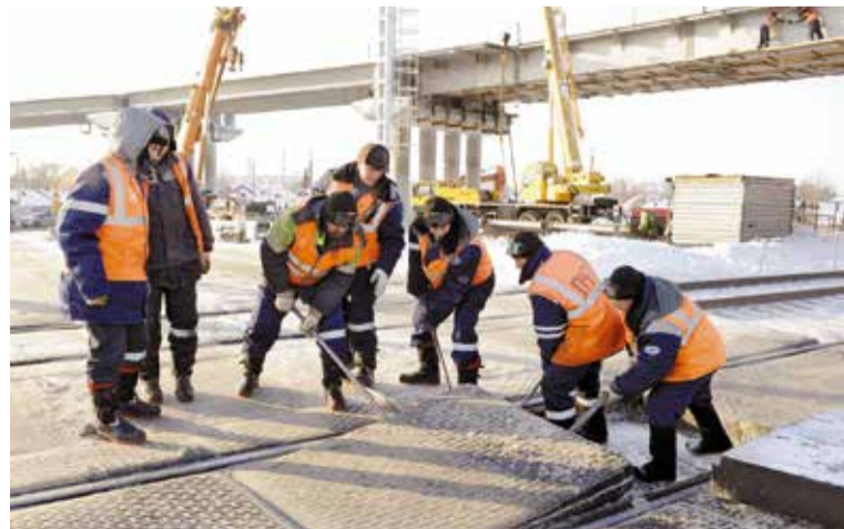
В 2016 году будет сдан в эксплуатацию очередной путепровод — на пересечении улиц 15-я Рабочая и Хабаровская
