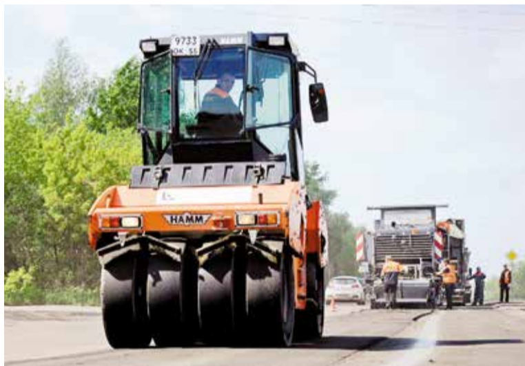
В округе отремонтировано 12 дорог
