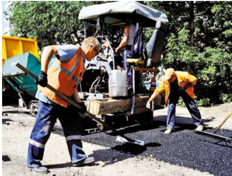
Ремонт во дворах завершится до 15 сентября
