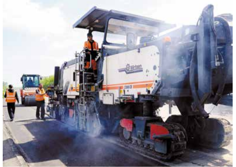
При ремонте дорог активно используются новая современная техника и технологии
