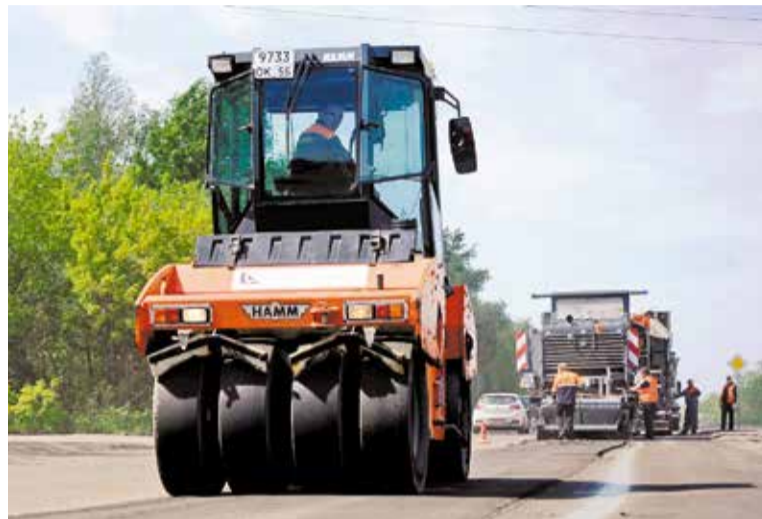
Отремонтировано пять магистралей Левобережья
