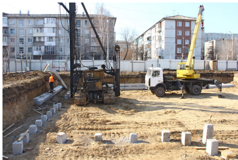
Начальный этап строительства детского сада в Кировском округе
