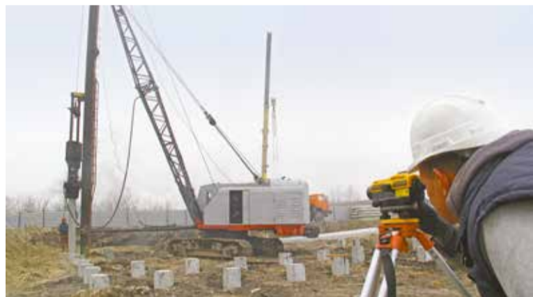
За качеством работ специалисты следят на каждом этапе строительства
