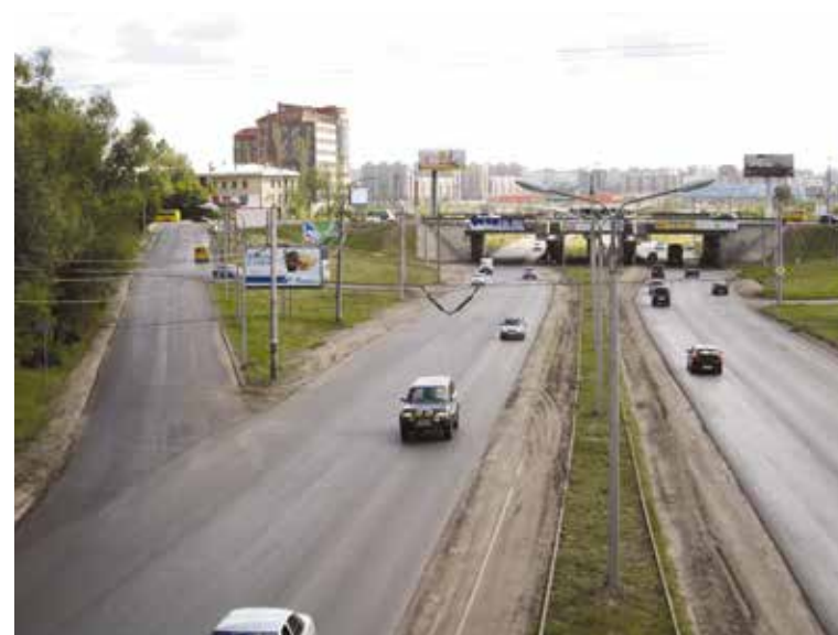
Вот так выглядит сегодня отремонтированная автодорога на улице Заозерной
