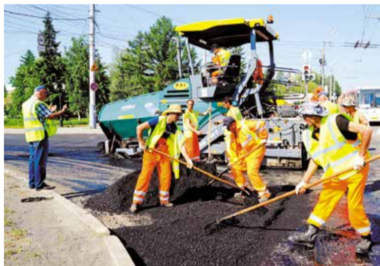
Покрытие заменено по всей ширине проезжей части
