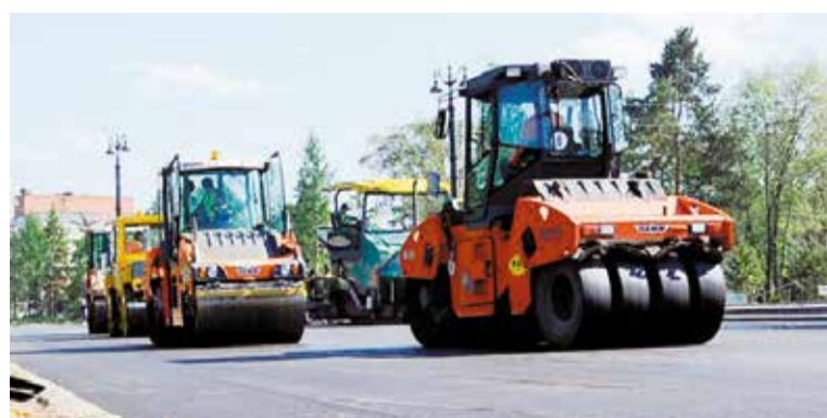
Завершающий этап асфальтирования
