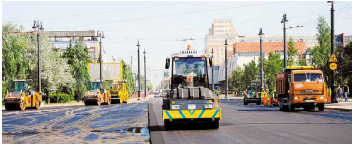
В этом году в Омске будет отремонтировано 57 дорог
