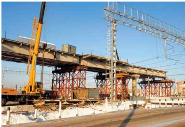
Полным ходом идет строительство путепровода на пересечении улиц 15-я Рабочая и Хабаровской
