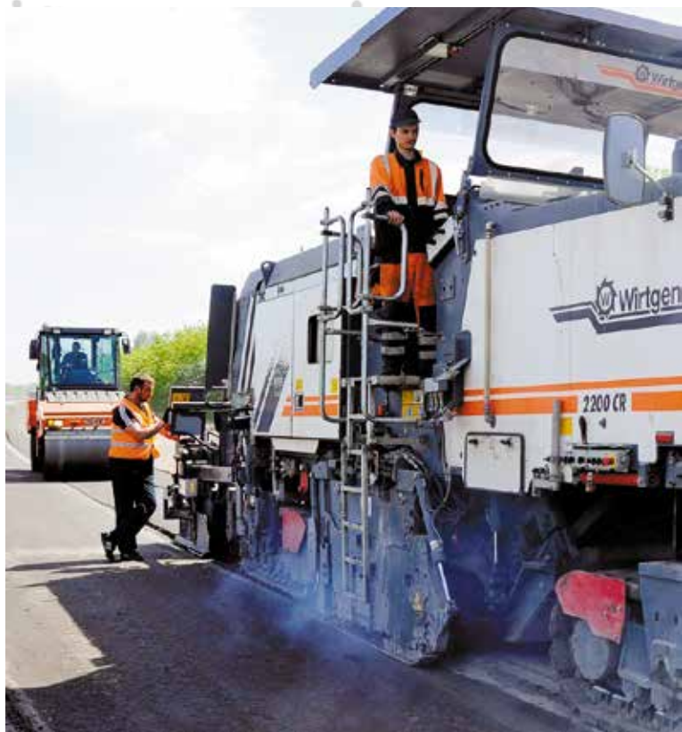
В 2017 году на ремонт дорог в Омске было направлено около 1 млрд. рублей
