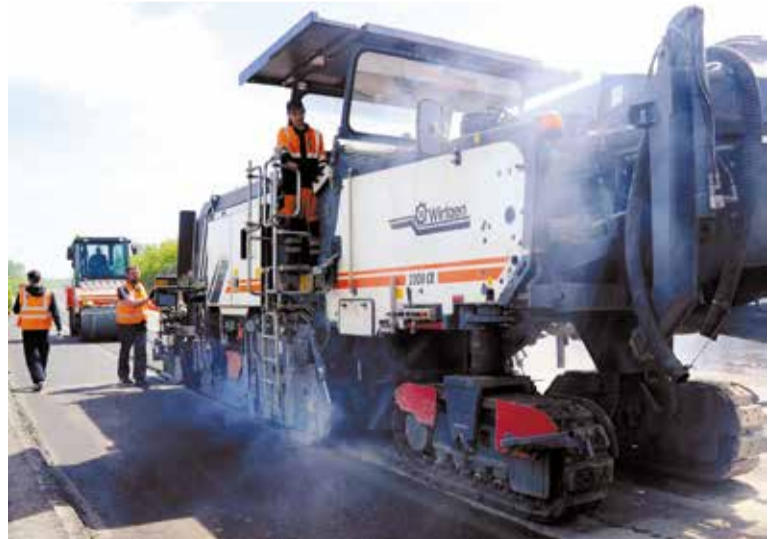
При ремонте дорог применяются новые технологии
