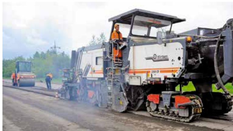
При ремонте дорог применяются современные технологии
