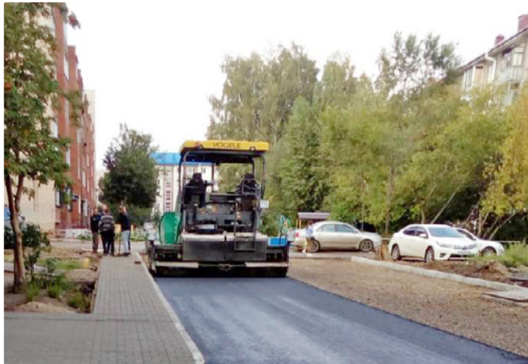
Укладка асфальтового покрытия
