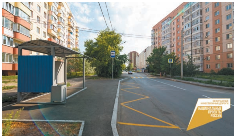
Дороги ремонтируются комплексно – с обустройством остановочных комплексов, тротуаров и ливневой канализации, установкой светофоров и дорожных знаков
