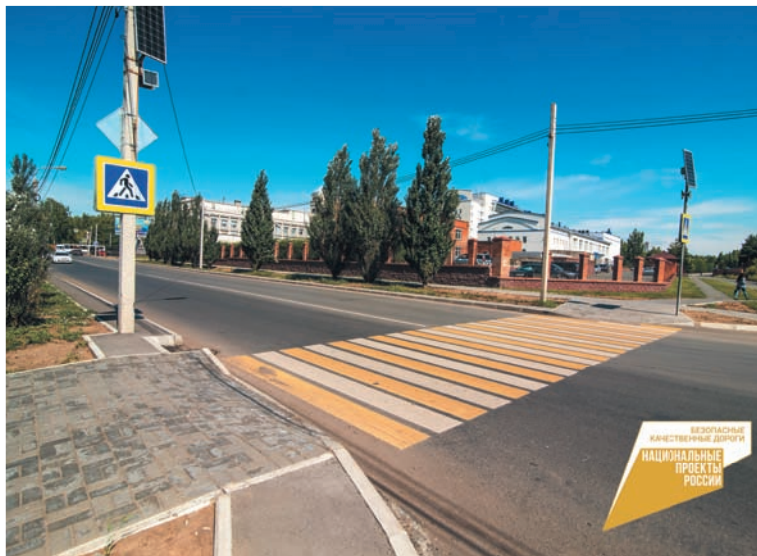
Дорогу по ул. 2-й Кольцевой обновили по нацпроекту «Безопасные качественные дороги»
