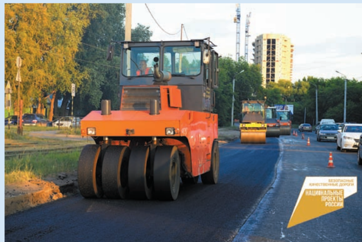
Комплексный ремонт улицы Маршала Жукова
