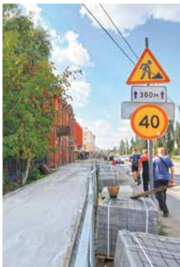
Работы на ул. Лермонтова
