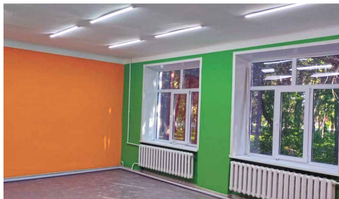
Ремонтные работы в рамках меценатской помощи в школе № 15 завершены
