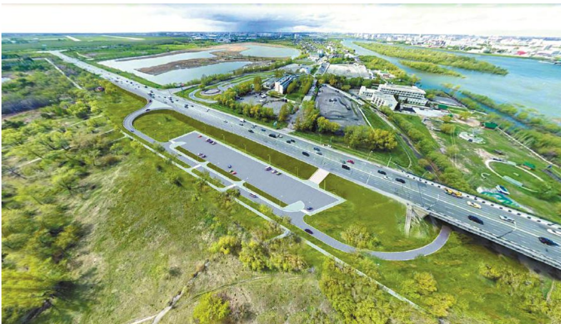
Капитальный ремонт Ленинградского моста начнется в сентябре
