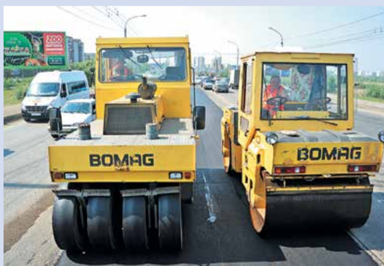
Ремонт дороги на ул. Лукашевича
