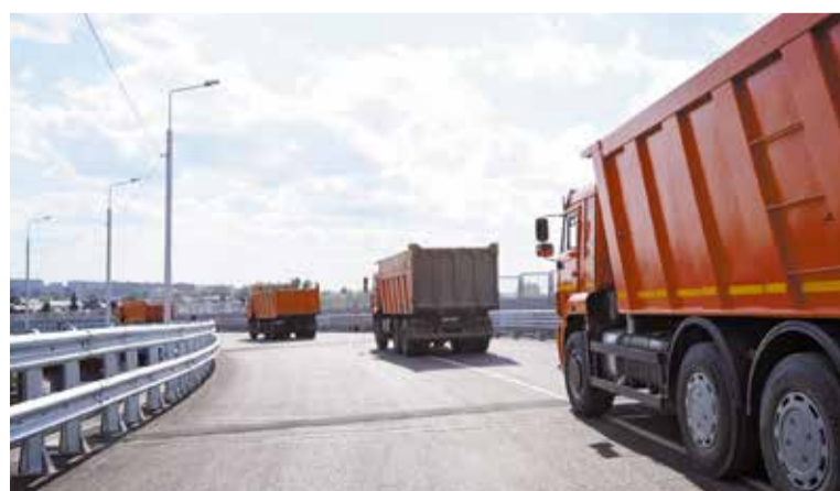
Путепровод на 15-й Рабочей соединил Ленинский и Октябрьский округа
