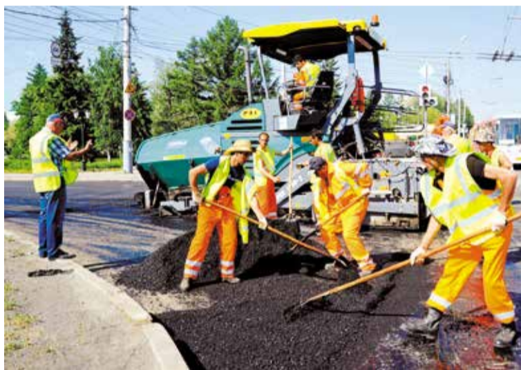
Основной ремонт городских дорог в Омске завершился 30 сентября
