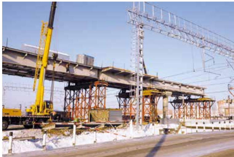
Путепровод на пересечении улиц 15-я Рабочая и Хабаровская будет введен в эксплуатацию в этом году
