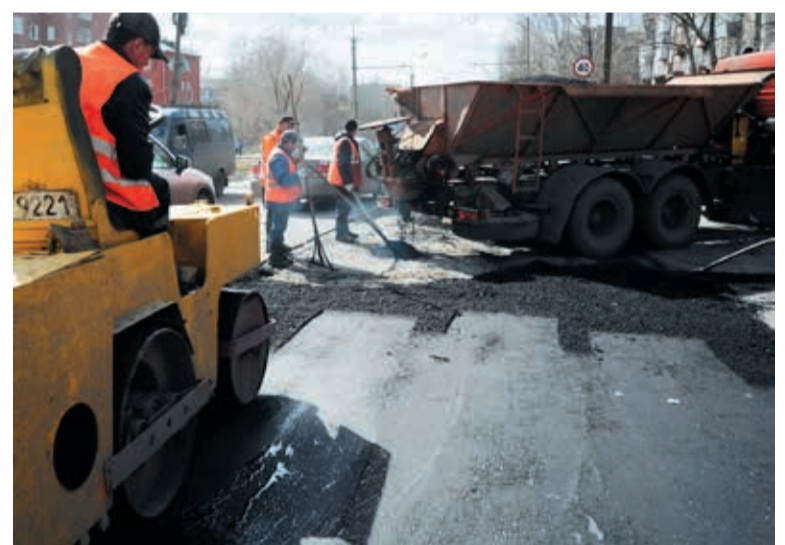
В этом году планируется выполнить аварийно-восстановительный ремонт на 348 наиболее участках дорог
