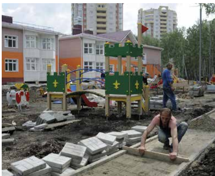
Жители сами определяют, благоустройство каких дворовых территорий и межквартальных проездов будет выполнено в ближайшие годы
