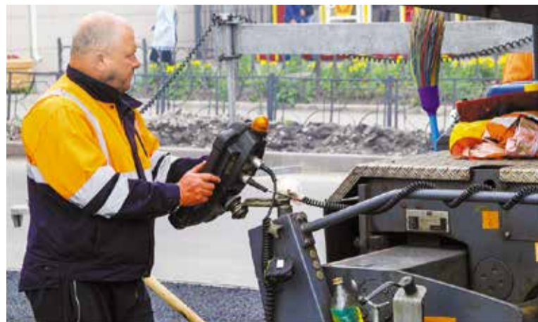
Ремонт дорог проводился с использованием новых технологий
