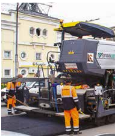
В округе по программе отремонтировано 5 дорог
