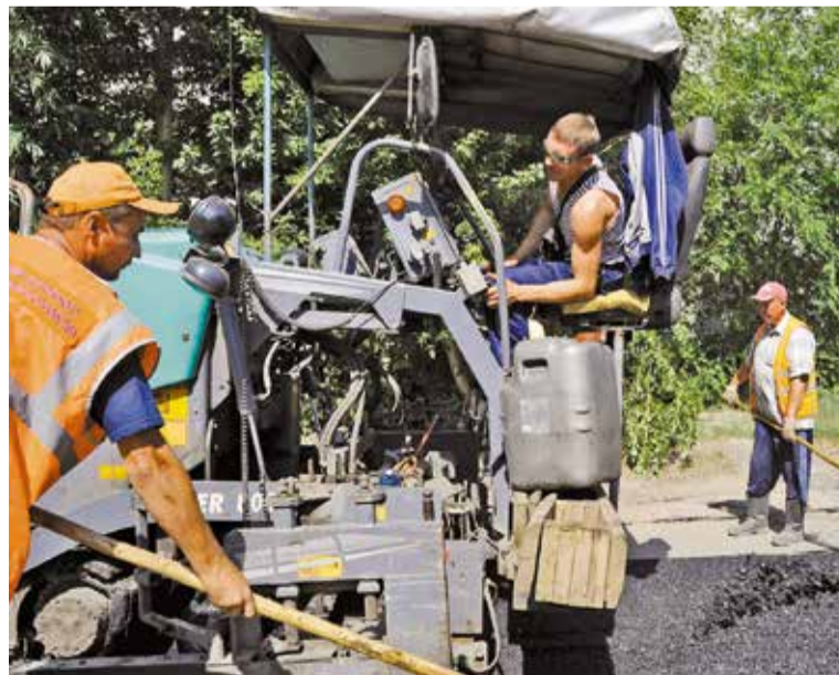
В Ленинском округе в прошлом году было отремонтировано 34 двора
