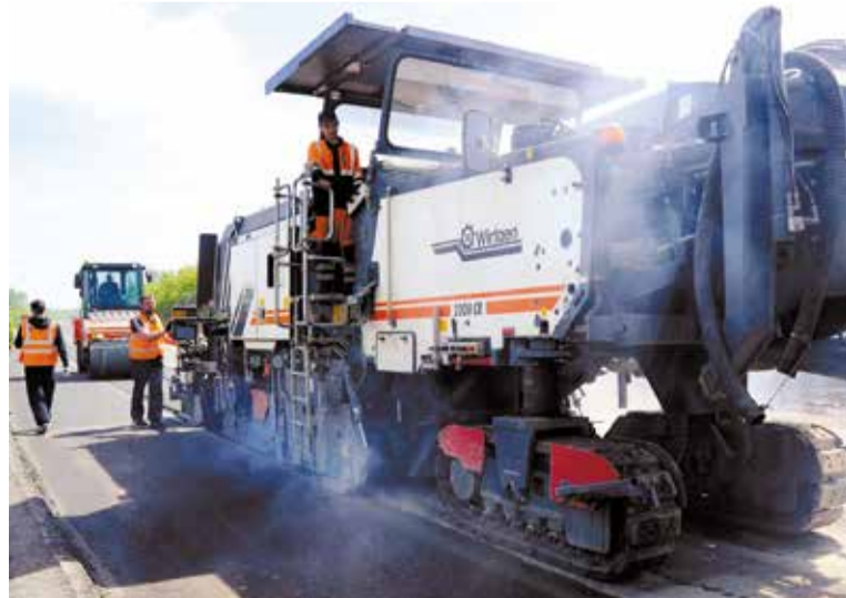
При ремонте дорог применяются новые технологии
