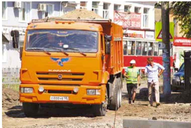
Работы по благоустройству территории у школы № 162 идут полным ходом
