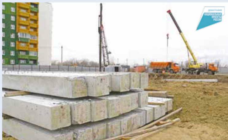
Подрядная организация уже приступила к строительству детского сада по улице 1-й Станционной
