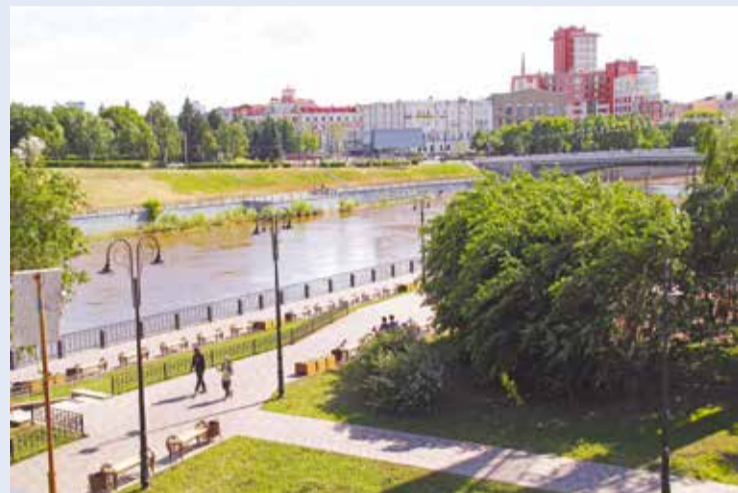
В Центральном округе на улице Бударина выполнен первый этап работ
