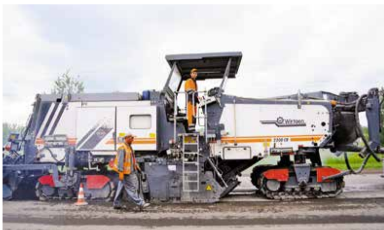
В Омске продолжится ремонт дорог по нацпроекту
