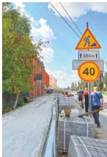
Работы на ул. Лермонтова
