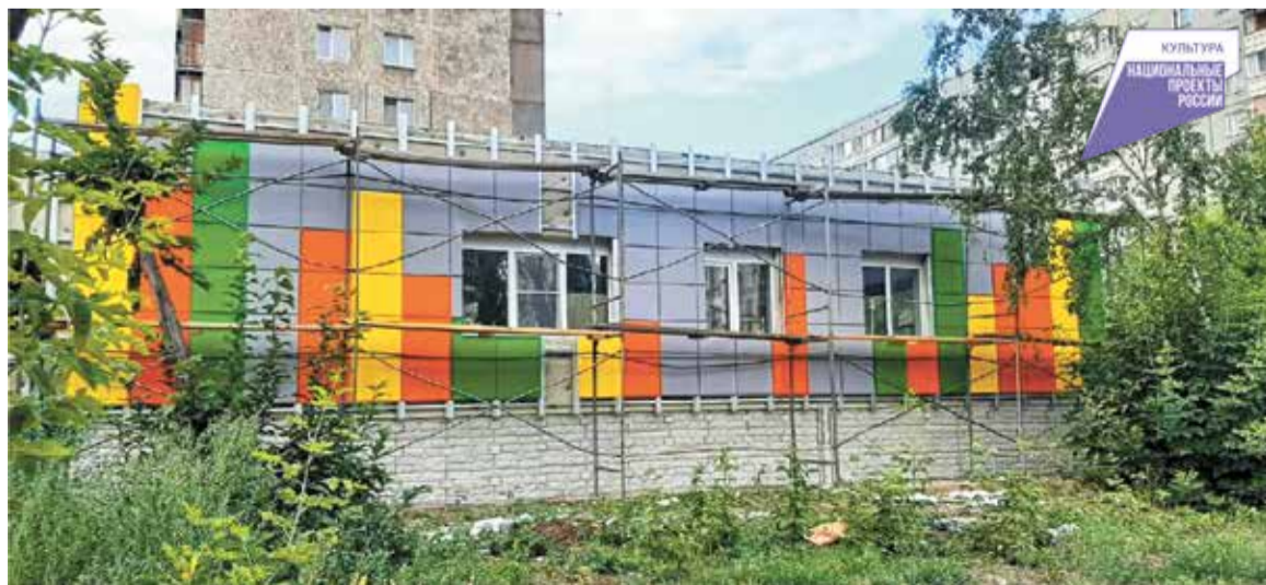
Ремонт фасада здания и входной группы подходит к завершению
