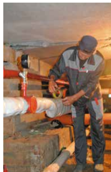
Установка новой теплоизоляции в жилом многоквартирном доме
