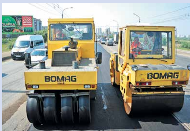
Ремонт дороги на ул. Лукашевича
